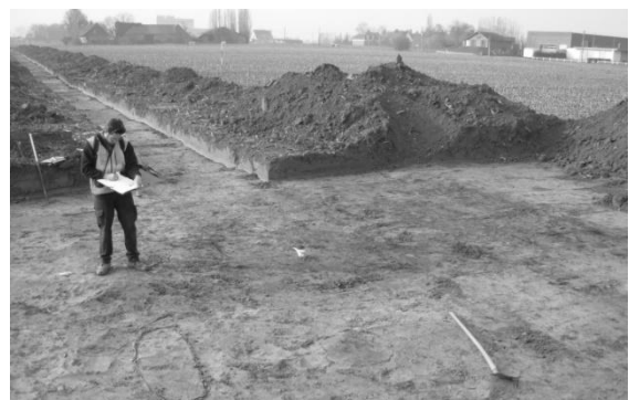
De tijdelijke veldoven voor baksteenproductie met op de achtergrond linksboven het 'Goed Ter Biest' (Foto: IOED-TERF)
